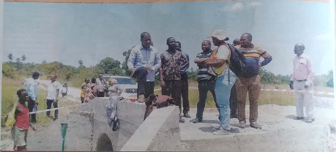
NAIBU Waziri wa Mifugo na Uvuvi ambaye pia ni Mbunge wa Jimbo la Mkuranga, Abdallah Ulega, akikagua maendeleo ya ujenzi wa Barabara ya Sangasanga-Sotele, Kata ya Dondwe, mkoani Pwani, mwishoni mwa wiki. Watatu kulia ni Mhandisi wa Kampuni ya Ujenzi ya Eagle Investment inayojenga barabara hiyo, Hilda Makelelo. (Picha na Scolastica Msewa).
