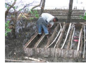
ujenzi wa vizimba vya kaa
